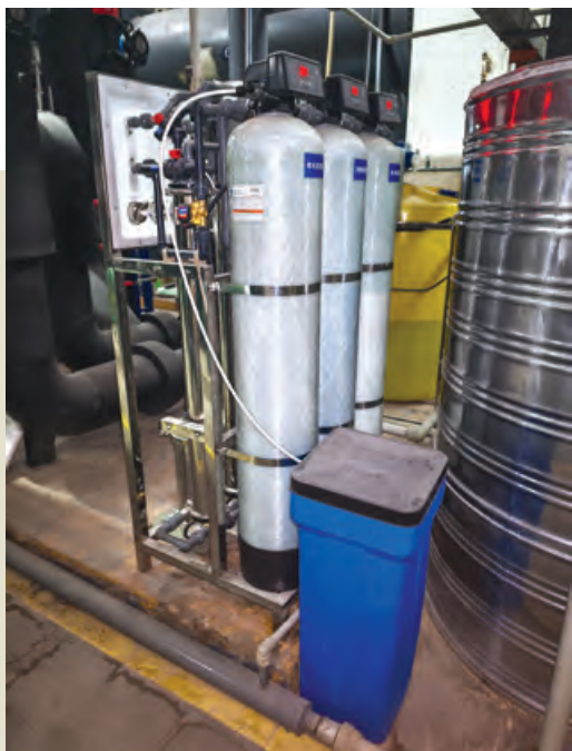
重慶大都會東方廣場所安裝的反滲透過濾系統，以減少游泳池及噴泉的用水量
